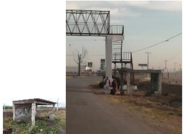
PB 15 Parabús/muro de block en muy malas condiciones, maleza.
