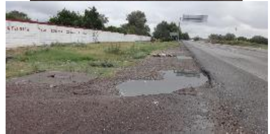
PB 20B Terracería con encharcamientos, sin Parabús.
