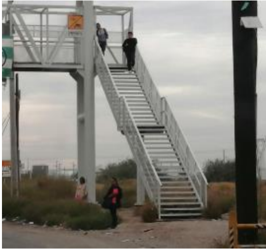
PB 1A Superficie de terracería, sin Parabús
