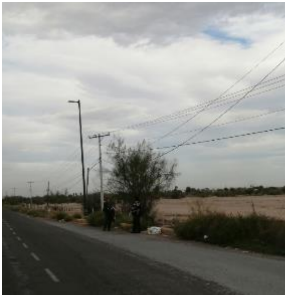
PB 14B Terracería/maleza en espacio insuficiente. Sin Parabús
