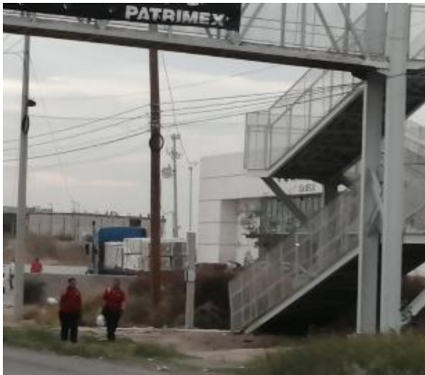
PB 4A Superficie de terracería sin Parabús.
