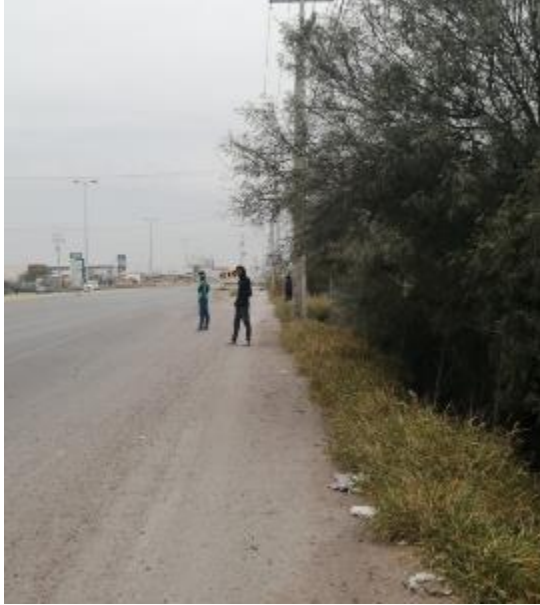
PB 8B Superficie de concreto sin Parabús.
