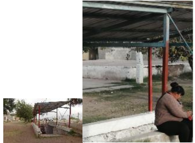
PB 12 Parabús con tubos de acero en malas condiciones.
