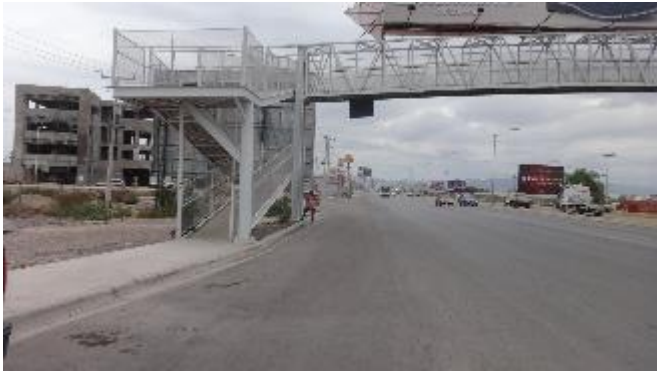
PB 5A Banqueta de concreto sin terminar, sin Parabús.
