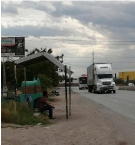
PB 10 Parabús con tubos de acero en malas condiciones.
